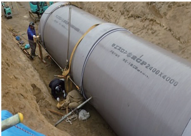
【狭小地鋼矢板・360°砂基礎】大阪市 φ2400 (外圧2種管)
