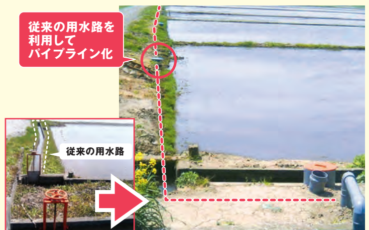
事例.2 従来の用水路をパイプライン化
