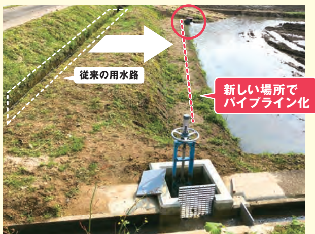
事例.1 従来の用水路の横に、新たにパイプラインを敷設
