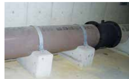
φ500大阪府浄水場内配管 鋼製継輪で落とし込み配管を実施
