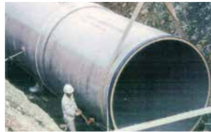
φ2600福井県共同事業 管接合状況
