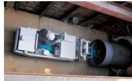
φ1000山口県工業用水道配水管 管路更生 バッテリーカーで運搬開始
