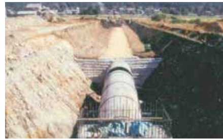
φ2600福井県共同事業 農業用水・水道用水・工業用水の導水管で採用
