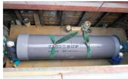
φ1000山口県工業用水道配水管 管路更生 管の吊降ろし(カゴ型台車とバッテリーカーをセット)
