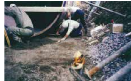
φ2600福井県共同事業 管底部の締固め
