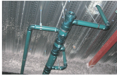
■新築(天井部の排水管)
