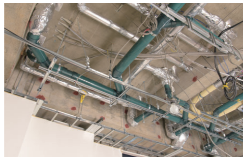
■改修(天井部の排水管)
