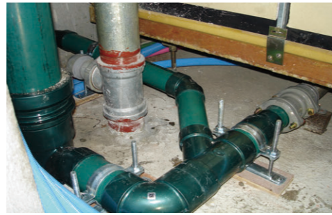
■改修(横枝管は従来管と接続)
