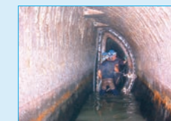
●更生前 管路内状況
