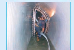
●更生中 管路内状況
