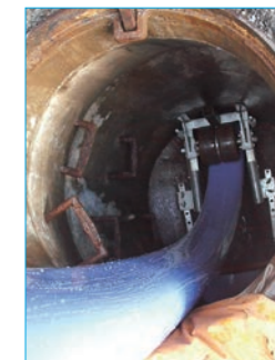
管の引き込み
