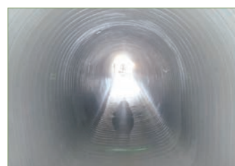
● 施工状況(馬蹄形)
