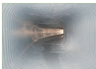
● 施工後の管内状況 (曲線部分も施工可能)
