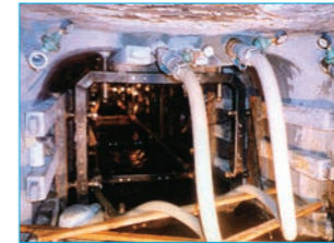
●モルタル注入状況
