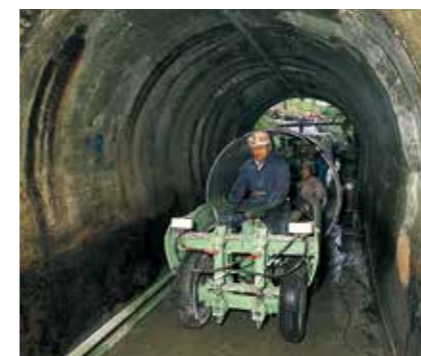
隧道改修 (リフトイン工法)
