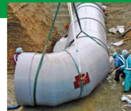
曲線配管 (同質曲管)
