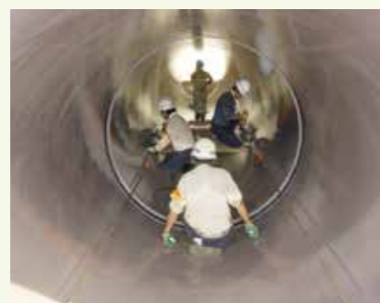
管の接合:内面接合方式
