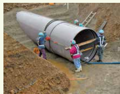
管の接合:外面接合方式
