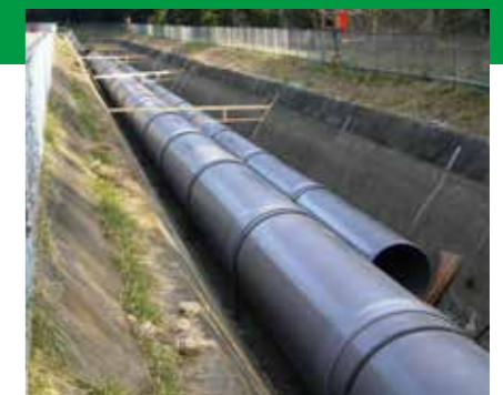
暗渠化 (水路内配管)
