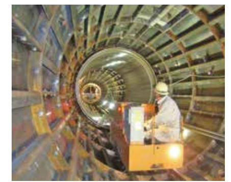
シールド二次覆工
