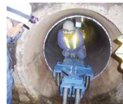
PC管改修 (リフトイン工法)
