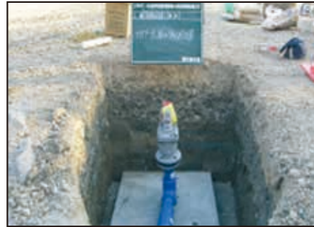
埋設消火配管
