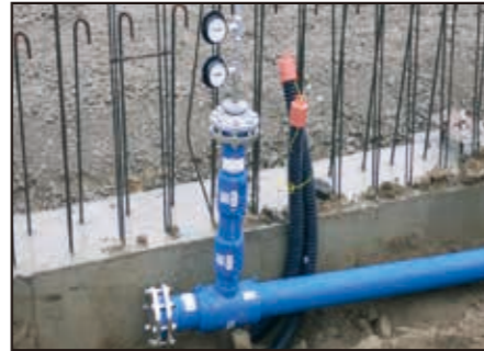
消火栓との接続
