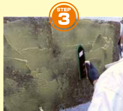
STEP 3 貼付けプライマー塗布
