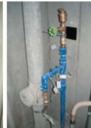
最上階空気弁
