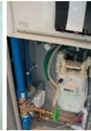
最下階ゲートバルブ付近
