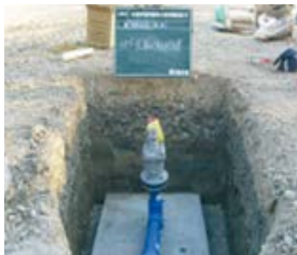
埋設消火配管
