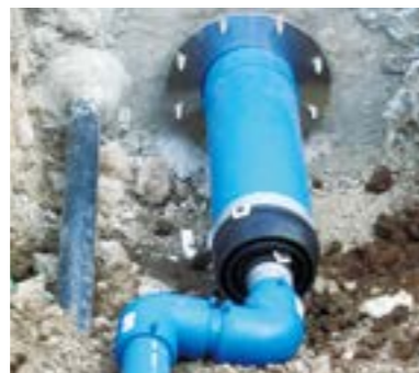
基礎耐震施工状況
