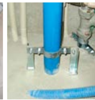
スラブ面の支持固定 (床バンドと足を用了支持固定)
