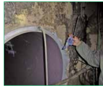
⑥裏込め材打設
