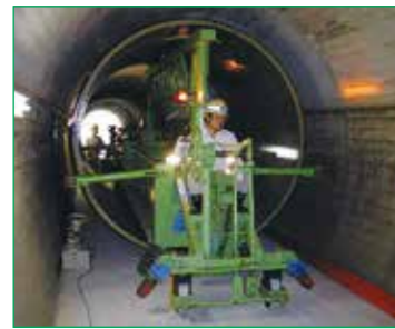
④既設水路内運搬
