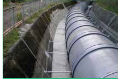
開水路改修(曲げ配管)
