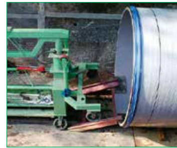
③運搬台車の引き込み
