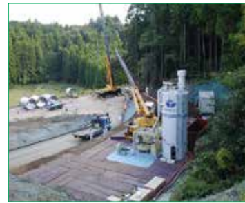
①管搬入立坑の設置
