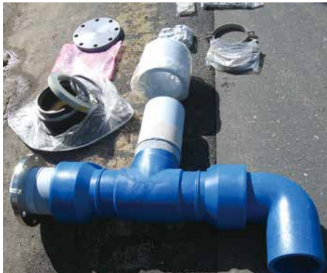
マンホール内副管
