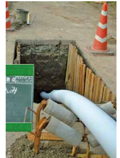
推進工事 (HDD 工法)
