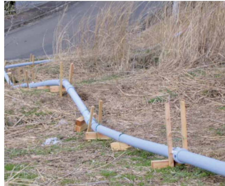
仮設配管 (震災復旧)
