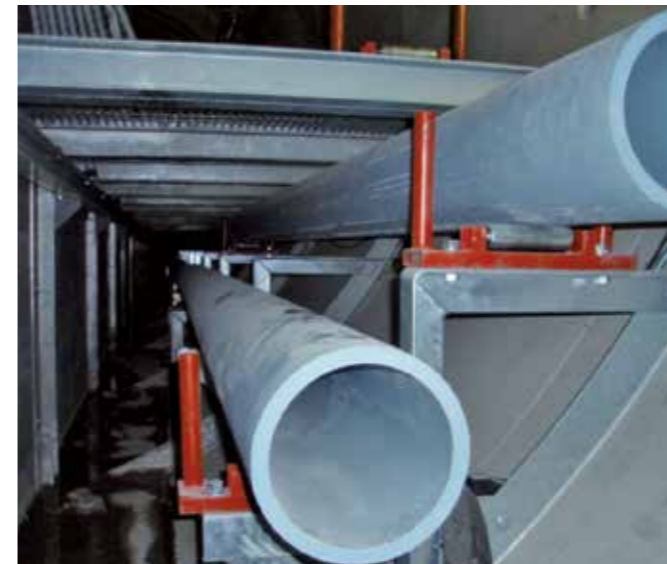
処理場連絡管路 (汚泥管路)
