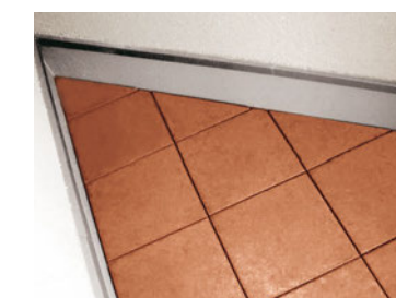
変形のバルコニーの端部
