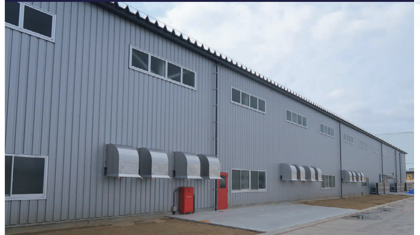
滋賀県栗東市 工場 | 超芯V500+高排水VP75 屋根投影面積:3,800m 2 /建物高さ:9m
