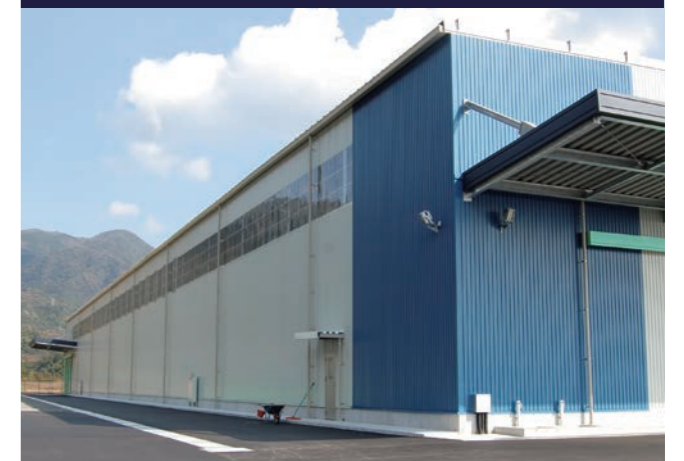
福岡県直方市 工場 | 超芯V500+高排水VP75 屋根投影面積:4,000m 2 /建物高さ:9m
