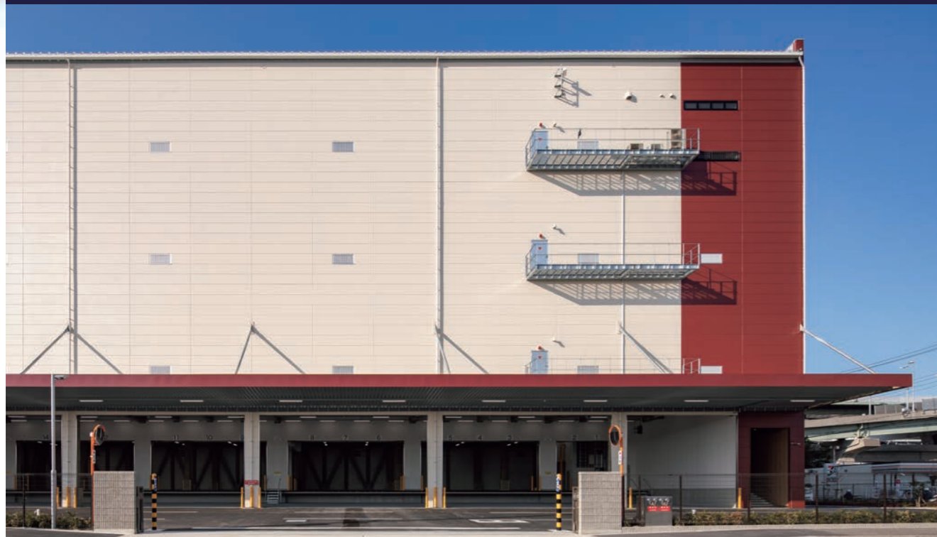
大阪府大阪市 物流センター | 超芯V500+高排水VU75 屋根投影面積:4,300m 2 /建物高さ:28m
