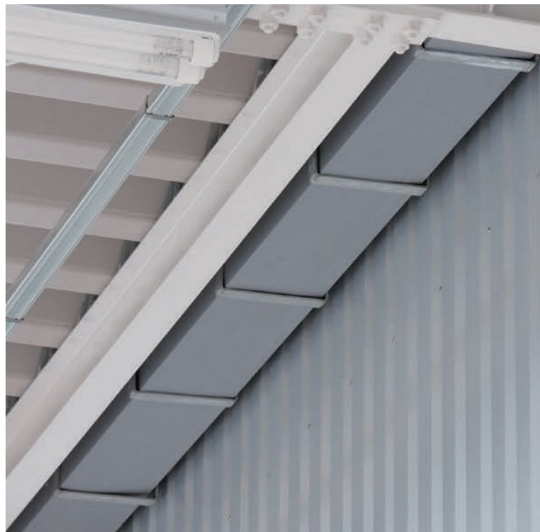
エスロコイル施工例
