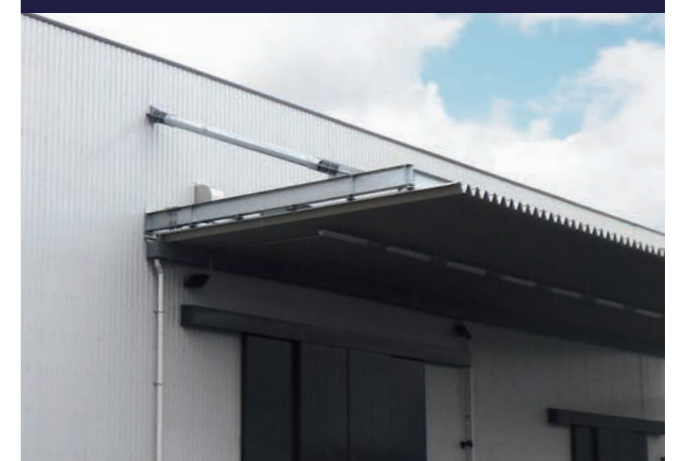
愛知県北名古屋市 工場 | 加工とい+高排水VP75 屋根投影面積:800m 2 /建物高さ:8m
