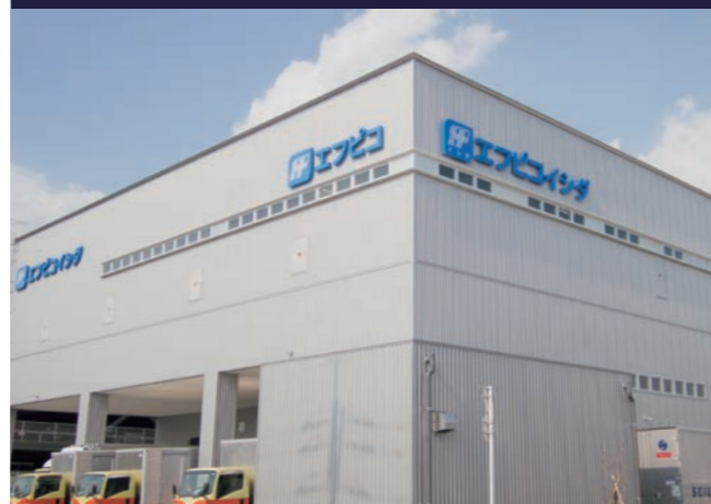
広島県広島市 事務所兼倉庫 | 超芯V500+高排水VP75 屋根投影面積:2,200m 2 /建物高さ:16m
