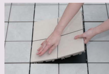
角をしっかり合わせ、連結部分を手で押さえるだけ。パチッと成れば連結完了。
