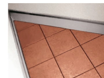
変形のバルコニーの端部
