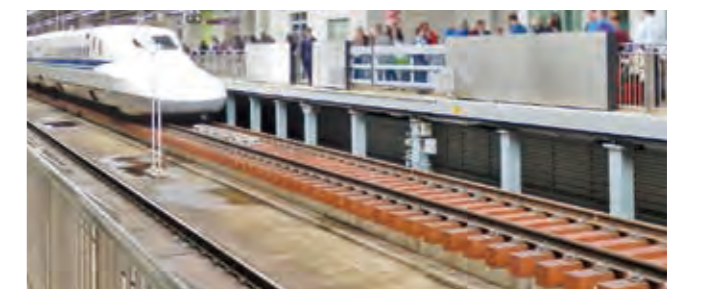
新大阪駅27番線のFFU製「まくらぎ」が設置された軌道
