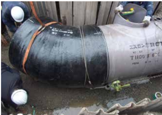
【造成雨水排水管】岡山県 φ600 (雨水3種管)
