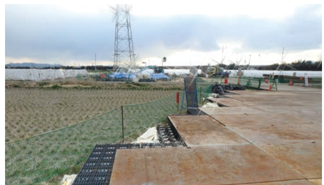
2016: Overhead power cable installation (Kumamoto)
