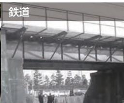
鉄桁ウェブ部に使用いただくことで桁からの放射音を低減します。
