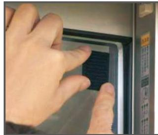
ステンレスコーティング面を太陽側にし、たるみがないように面ファスナーを必要箇所に取付けて貼ります。
