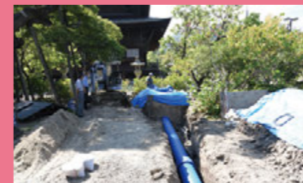
善光寺消火設備配管更新工事
