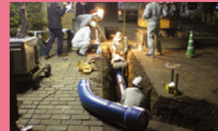
清水寺防災施設施工
