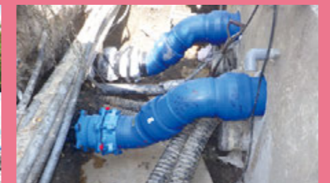
バルブヒットから既設管への接続(善光寺)
