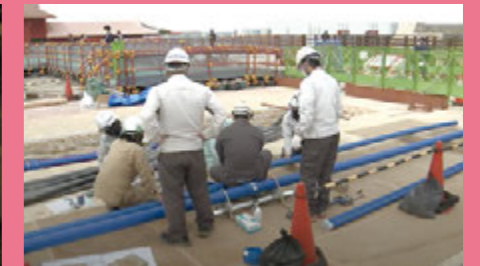
首里城連結送水管設置工事
