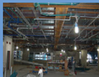
施工中の耐火VPパイプ・耐火DV継手
