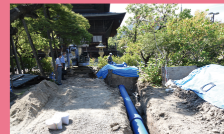
善光寺消火設備配管更新工事
