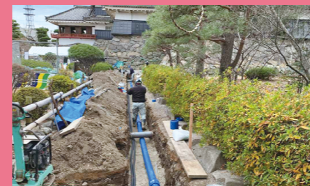
松本城防災設備工事
