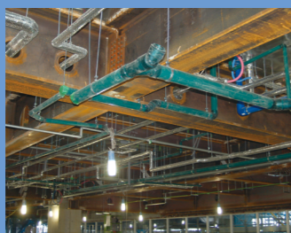
施工中の耐火VPパイプ・耐火DV継手
