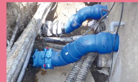
バルブヒットから既設管への接続(善光寺)
