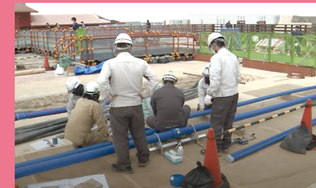
首里城連結送水管設置工事
