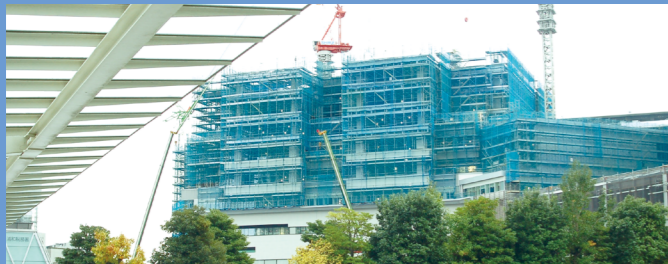
工事時の埼玉県立小児医療センター
