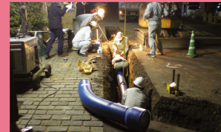
清水寺防災施設施工
