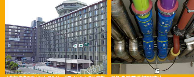
大規模改修工事が行われたリーガロイヤルホテル京都 2色の管で誤接続防止
