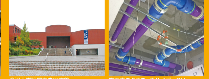
金沢大学附属中央図書館 施工中のクウチョウハイパーCH
