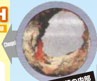
錆びた金属管の内部
