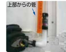
管をソケットに挿入する時は、管をパイプホルダーで固定せずに挿入してください。管を固定した状態で挿入すると、斜め挿入や挿入不足になるおそれがあります。
