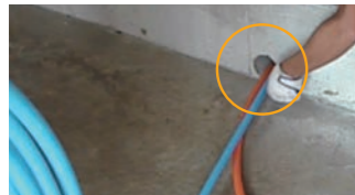
間仕切り基礎貫通の際、管表面に傷が発生しません。
