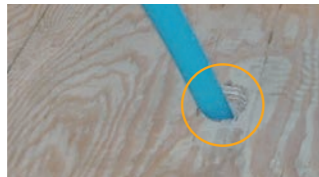
床下から引き上げる際も、管表面に傷が発生しません。
