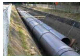
暗渠化(水路内配管)
