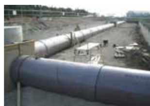
宅地造成(雨水排水管)
