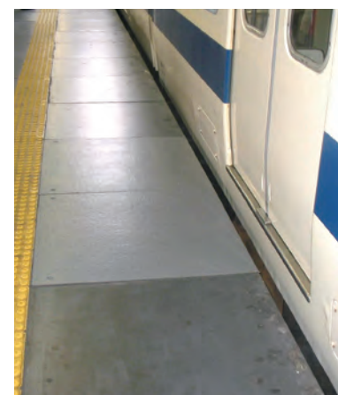
● プラットホーム
