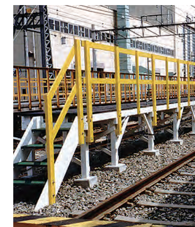
● 洗車場デッキ
