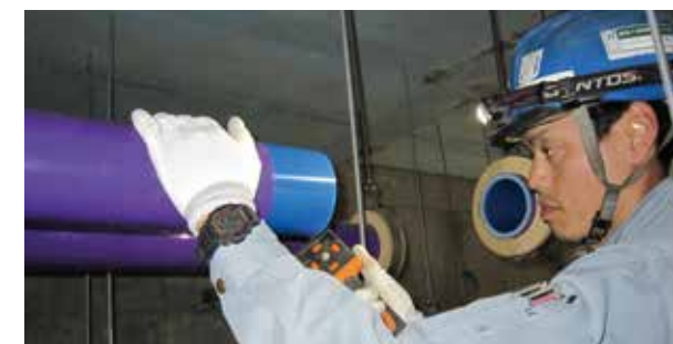
④融着面の切削（ハンスクレーパー）
