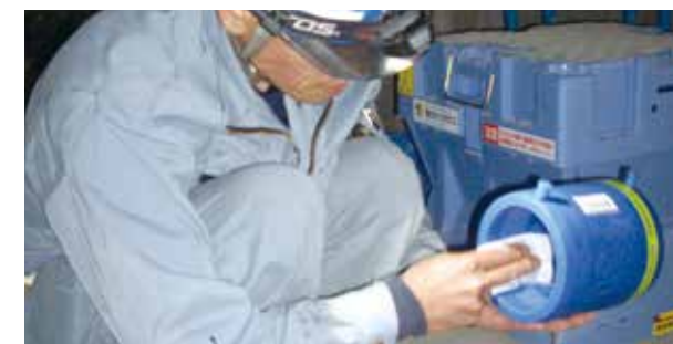
⑥融着面の清掃（継手側）
