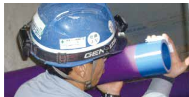
⑤融着面の清掃（管側）
