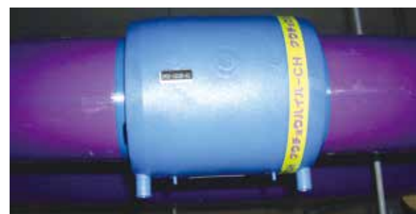
⑨クランプ保持後、取り外して融着完了
