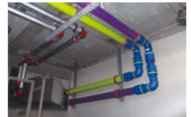
天井内配管 (2色の管の使用による誤接続防止)
