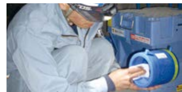
⑥融着面の清掃（継手側）
