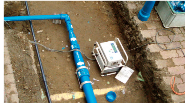
外構配管施工
