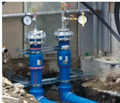
消火栓との接続 (左:エスロハイパー-AW高圧消火管・継手 右:エスロハイパー-AW消火管・継手)
