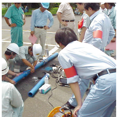
施工講習会風景
