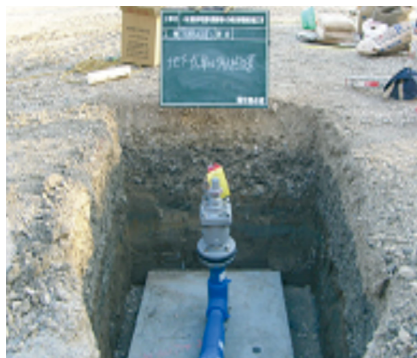
埋設消火配管
