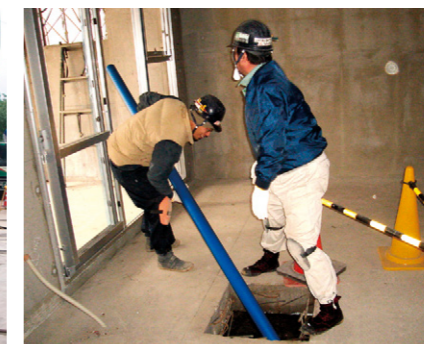
柔軟性を活かしたピット内への管の搬入
