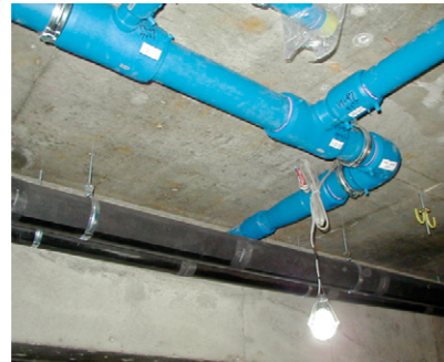
1階天井部チーズ分岐付近(保温が必要です。)
