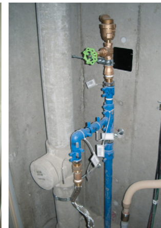
最上階空気弁
