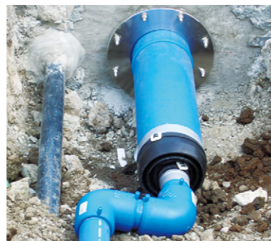
基礎耐震施工状況
