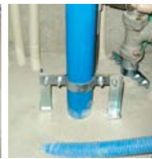
スラブ面の支持固定 (床バンドと足をを用いた支持固定)
