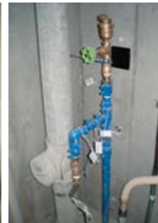
最上階空気弁
