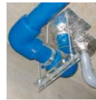
最下階継手での支持固定 (アングルとUバンドでの支持)
