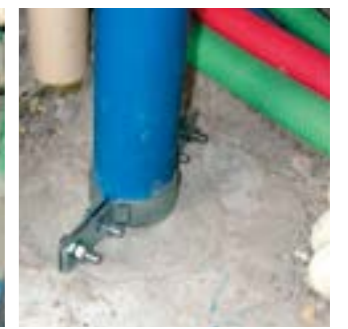
床バンドコンクリート埋設による固定 支持 (コンクリート増し打ち前)
