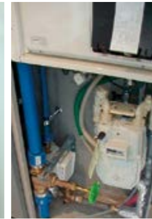
最下階ゲートバルブ付近
