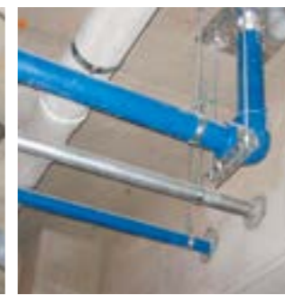
最下階継手での支持固定 (アングルとUバンドでの支持)
