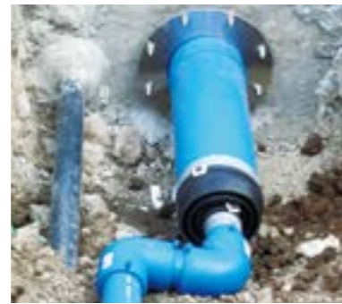
基礎耐震施工状況
