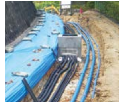
神社参詣道屋外消火栓の埋設配管
