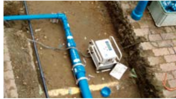
外構配管施工
