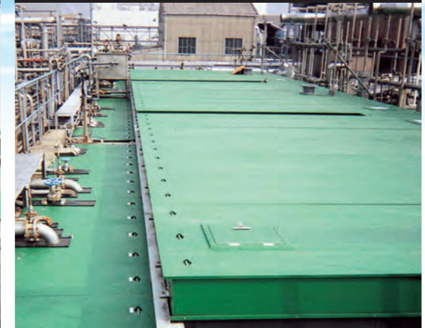
複雑な配管加工も容易なFFU製防臭蓋
