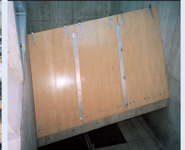
二階層沈殿池向け導水渠
