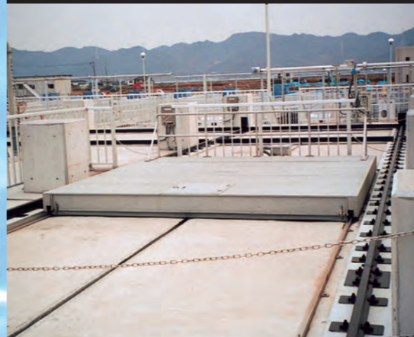
大開口でも軽量で開閉が容易なFFU製スライド蓋
