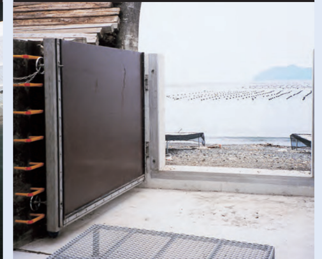
海岸に取り付けた防潮扉
