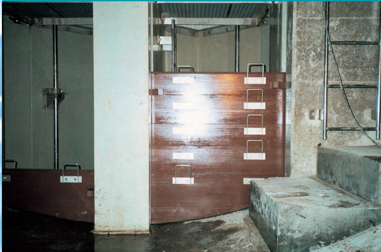
■人孔内角落し
