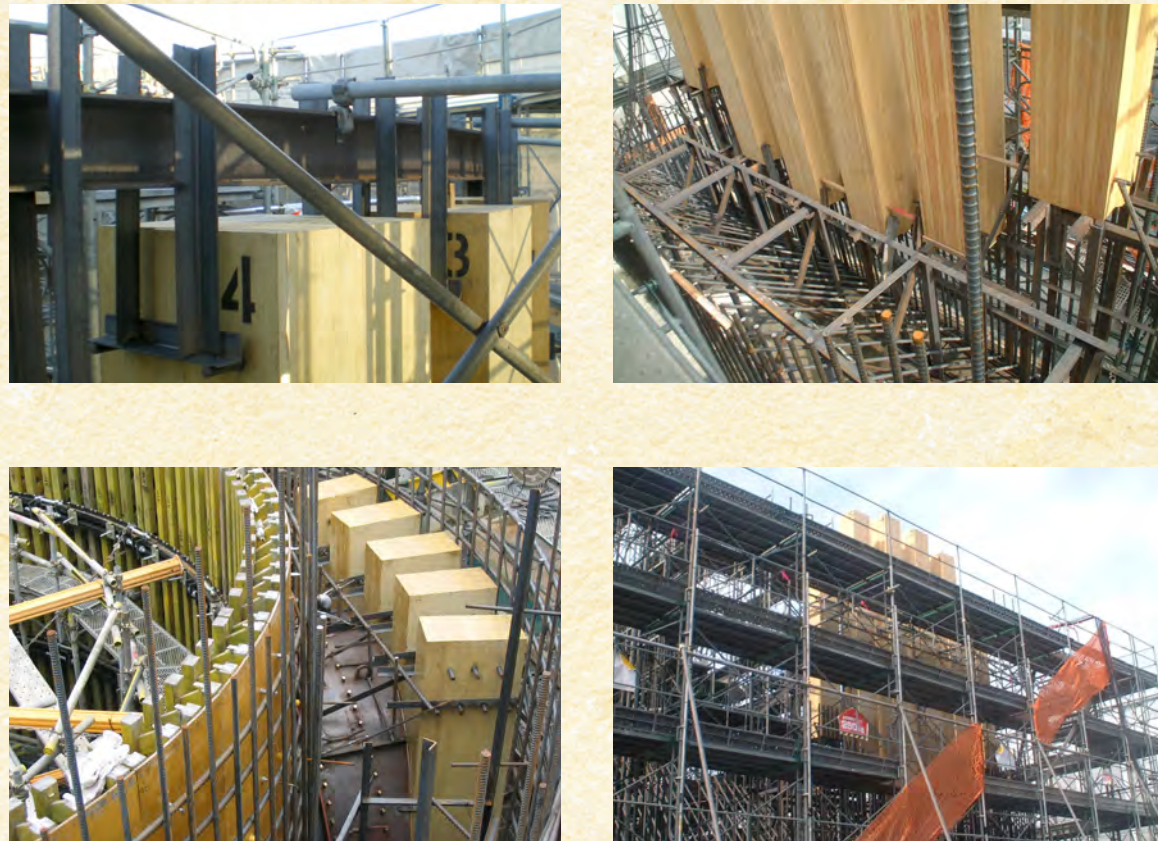
現場施工状況
