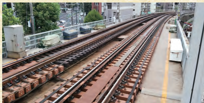
鉄道施設【橋枕木】
