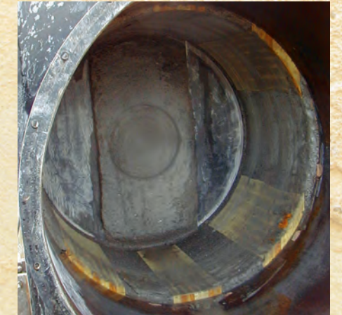
切削完了状態
