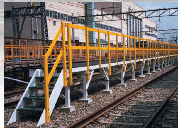
洗車場デッキ
