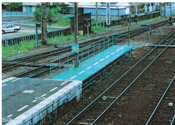
プラットフォーム延伸工事
