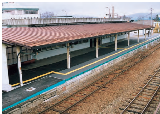
プラットフォーム高上げ工事
