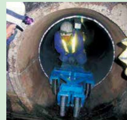
神流川沿岸農業水利事業 児玉幹線改修その7工事
