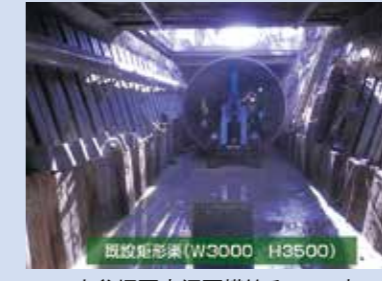
山谷堰雨水渠再構築その2工事
