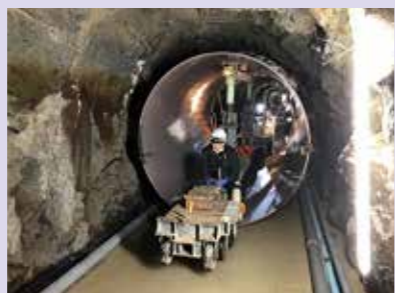
土樽発電所 導水路改修工事
