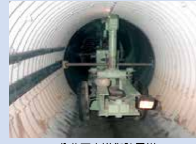
公共下水道御陣屋川第2-1幹線雨水渠築造工事
