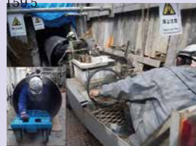
静岡県静岡工業用水道事業送水本線布設替工事 谷津隧道工区
