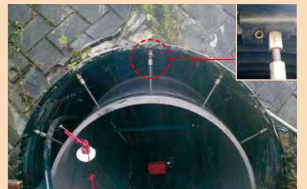
関越自動車道災害復旧工事KP217.866
