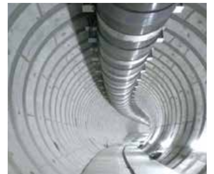
FRPM管設置完了
