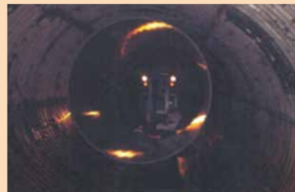
平成14年度広野地区他構造物補修工事
