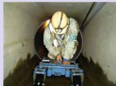
東京国際空港A7高速脱出誘導路舗装等工事
