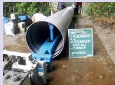
静岡工業用水上坂隧道上流工区
