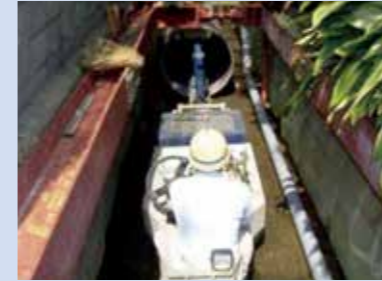
葛飾管渠布設工事(その50)
