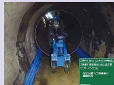
信夫山光大寺小水力発電建設工事
