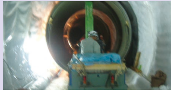
池田市第6次拡張事業配水隧道改良工事
