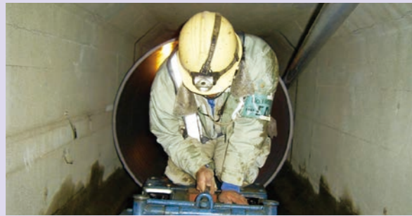
東京国際空港A7高速脱出誘導路舗装等工事
