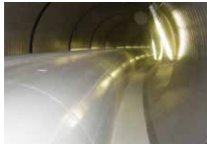
■多機能二次覆工（千葉ネットワーク幹線 φ2000）
