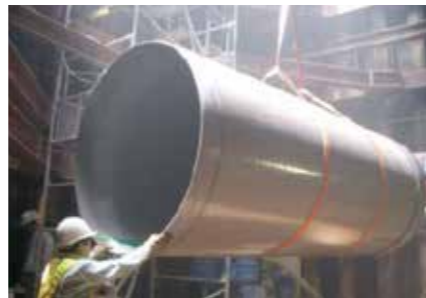
■管の吊り下ろし
