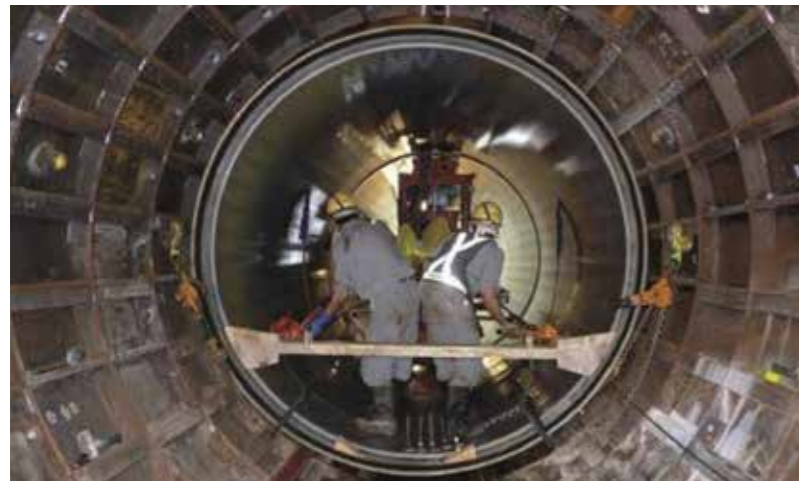
■内面挿入治具での接合状況
