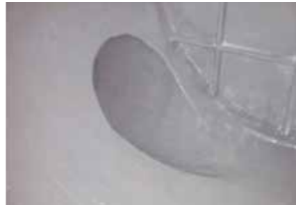
■枝管VUφ400との接続部
