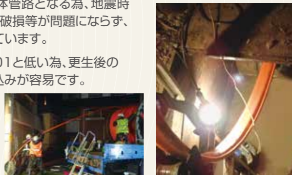
継手のないライナー材で一体管路に
