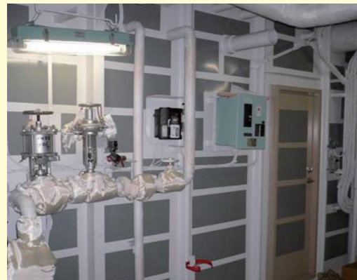
壁・床: エンジンルーム等からの振動伝搬による騒音を低減します。
