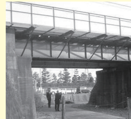
橋梁: 鉄桁ウェブ部に使用いただくことで桁からの放射音を低減します。
