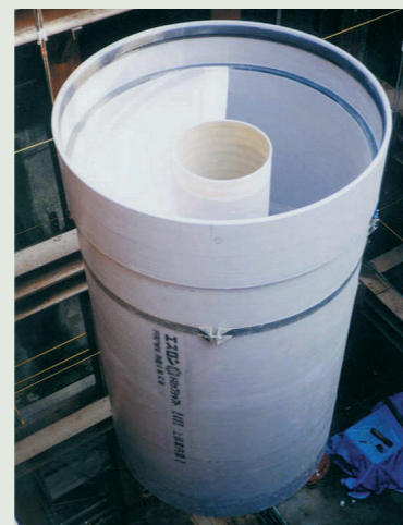
東京都 (浅草橋幹線人孔設置工事) 呼び径: φ2400 落差: 14.1m
