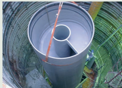
神戸市 (新兵庫高区汚水幹線) 呼び径: φ1350 落差: 13m
