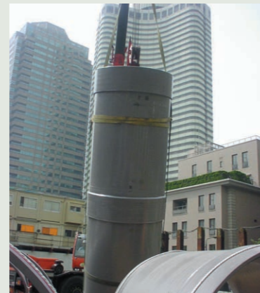
東京都 (溜池幹線人孔設置工事) 呼び径: φ1650 落差: 46.3m
