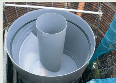
大阪市 (十八条～西島幹線) 呼び径: φ3000 落差: 34m
