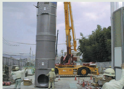
京都府 (桂川右岸流域下水道幹線管渠工事) 呼び径: φ1650 落差: 29.7m
