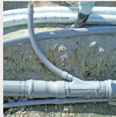
曲管(受口付)直線部での分岐管の布設
