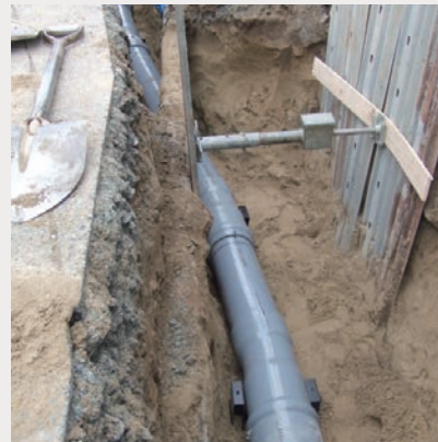
水道管の下越ししながらの障害物回避配管
