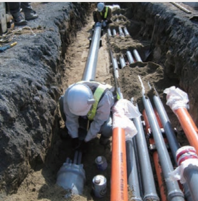
電線共同溝(一般部分)での配管
