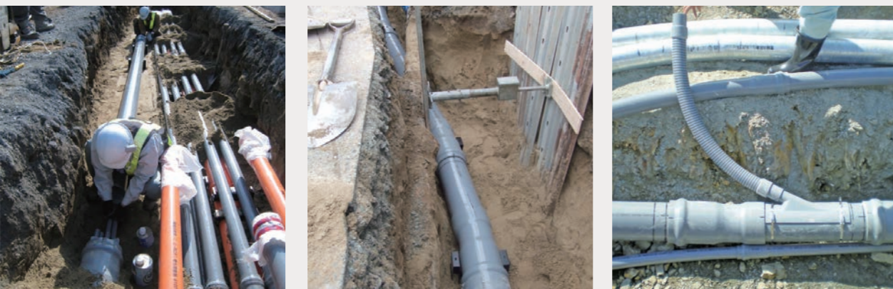
電線共同溝(一般部分)での配管 水道管の下越ししなからの障害物回避配管 曲管(受口付)直線部での分岐管の布設
