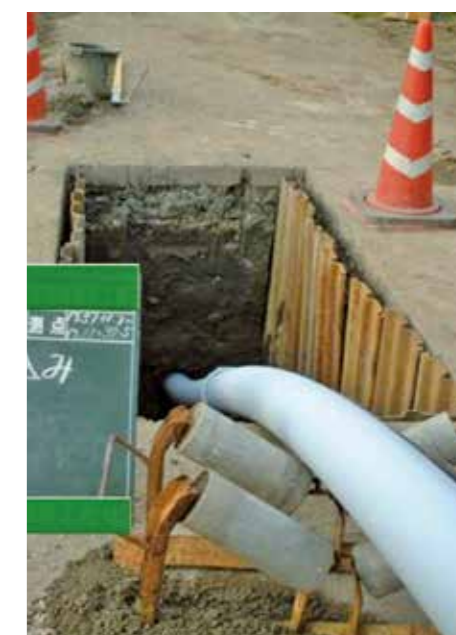
推進工事 (HDD 工法)
