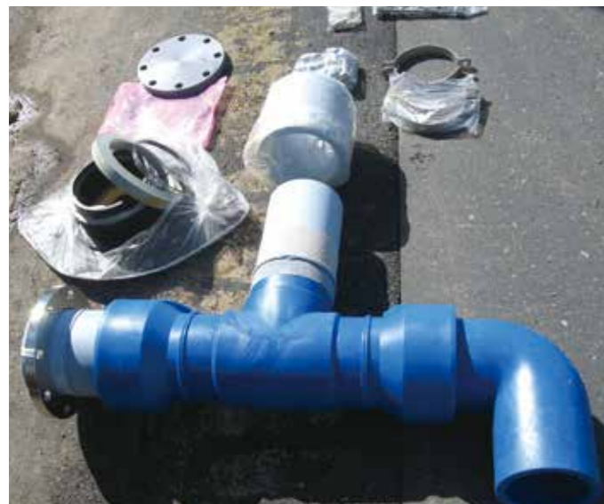
マンホール内副管
