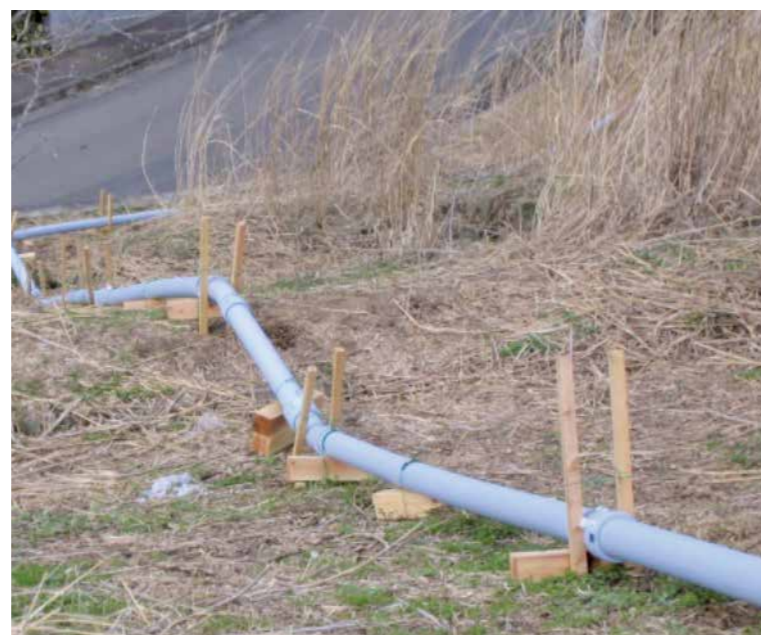
仮設配管 (震災復旧)
