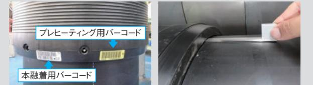
ゲージによる隙間寸法の確認
