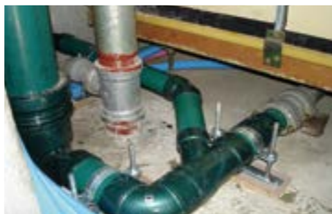
■改修(横枝管は従来管と接続)
