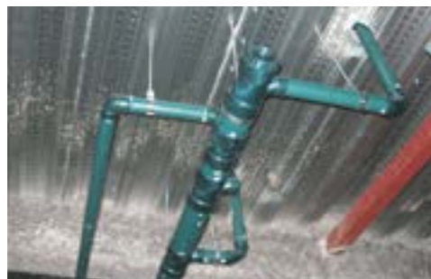
■新築(天井部の排水管)
