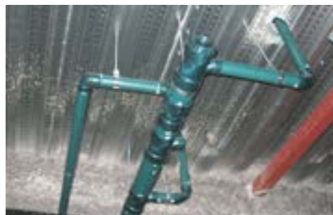
■新築(天井部の排水管)
