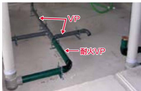
■改修(横枝管は従来管と接続)
