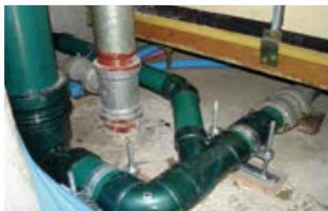
■改修(横枝管は従来管と接続)
