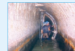
● 更生前 管路内状況
