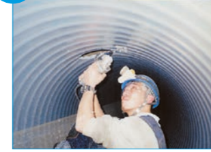
● 削孔(大口径の場合)
