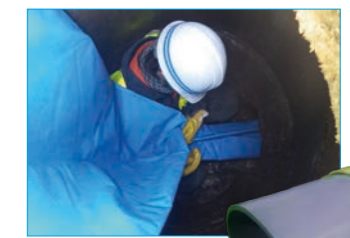
不明水発生現場も施工可能に!
