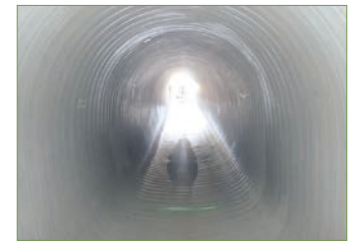
● 施工状況(馬蹄形)
