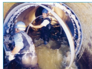
●施工状況(供用下での施工)
