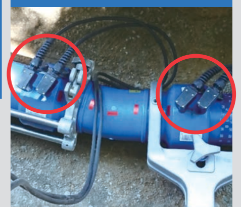
EF両受バンド 同時通電施工事例
