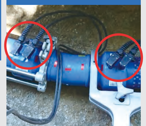
EF両受バンド 同時通電施工事例
