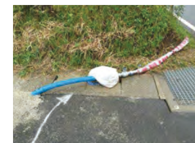
HPPE管からの仮設配管状況(露出部は他管種)
