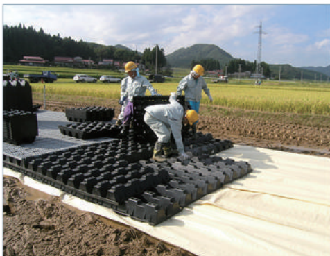
①プラロードを敷設
