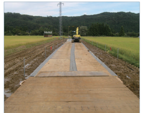
③上面に鉄板を敷設
