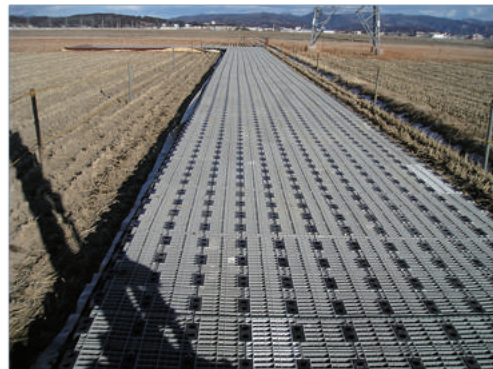
②スペーサーを敷設
