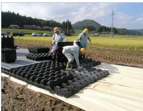
①プラロードを敷設
