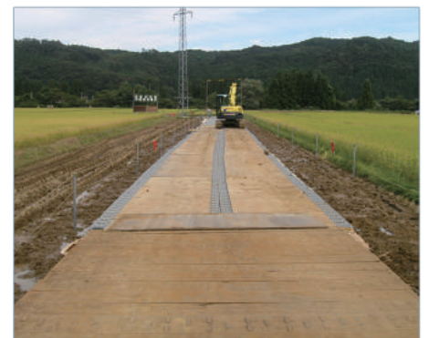
③上面に鉄板を敷設
