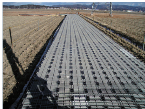
②スペーサーを敷設
