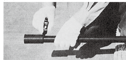
挿入長さとゼロポイントの確認
