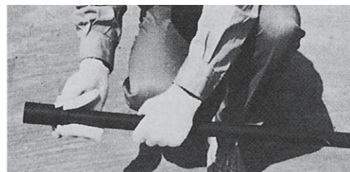
挿入長さとゼロポイントの確認
