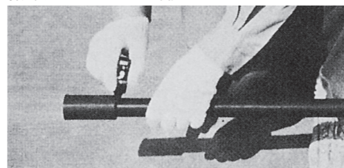
挿入長さとゼロポイントの確認
