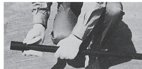
挿入長さとゼロポイントの確認
